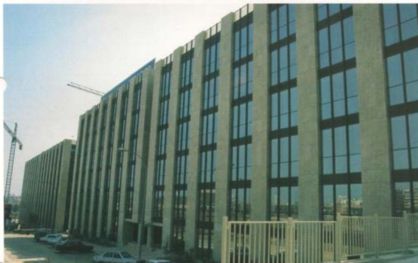
Edifici d'Oficines Euro-3 (Arq. Leonardo Glaser)
