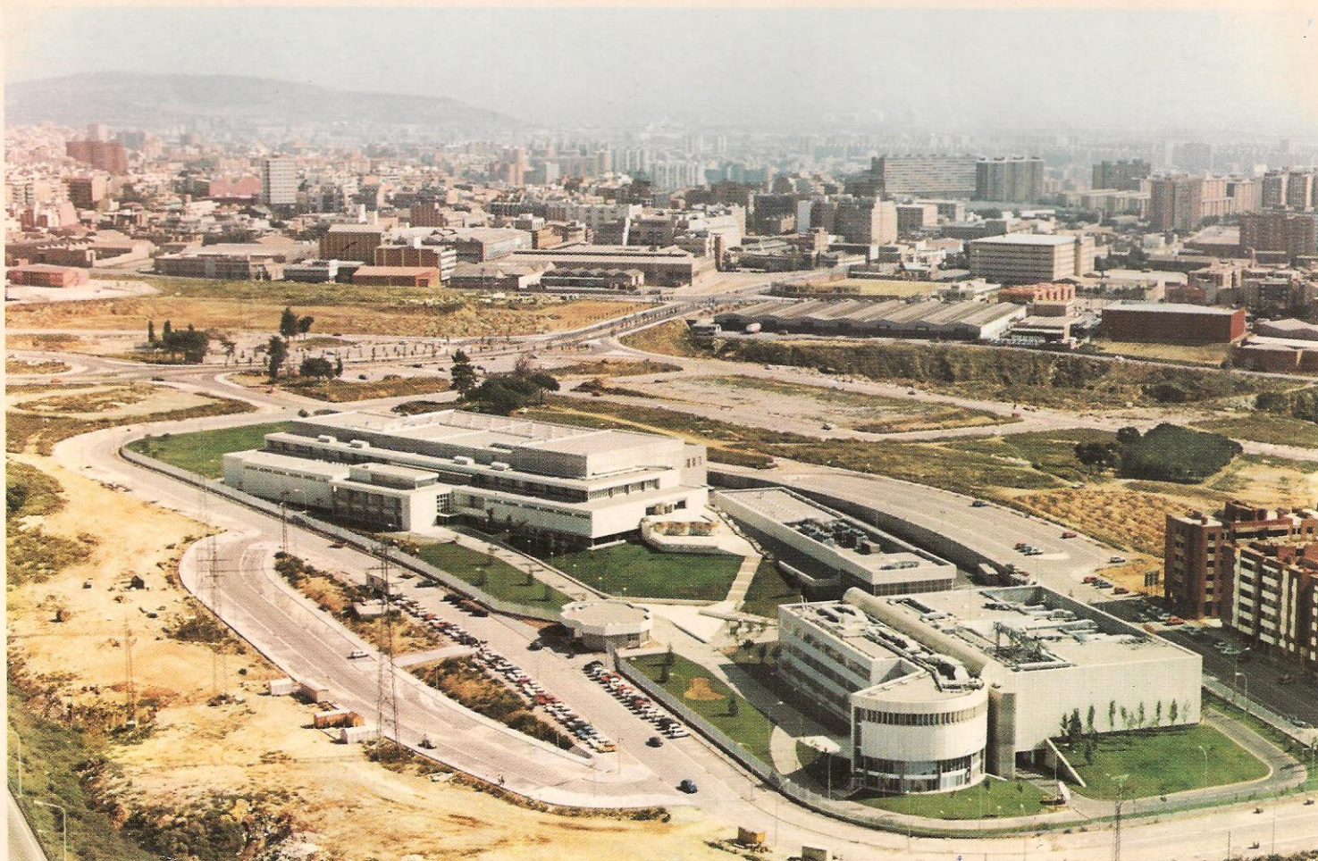
EDIFICIO TV3 SANT JOAN DESPI
