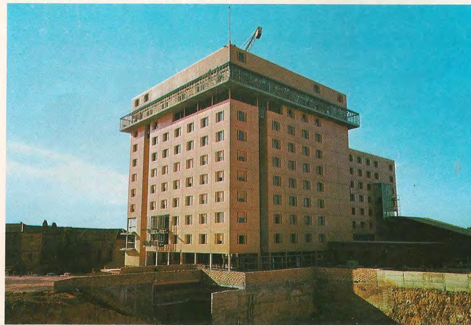
Residencia de la Congregación de Religiosas Hermanitas de los Pobres en Tarragona. Mod. N.º 398 E
