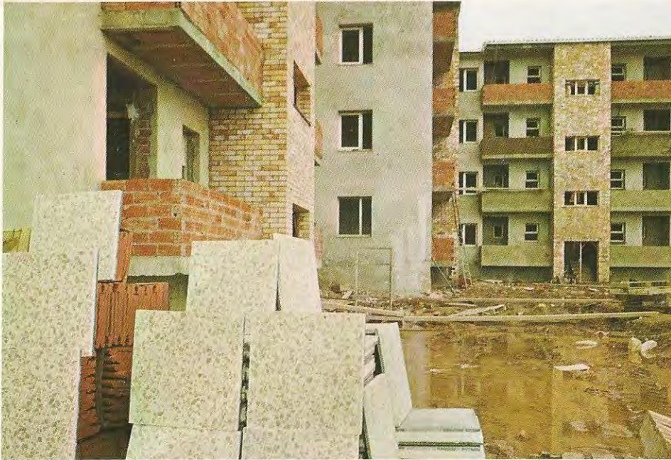
Viviendas en Construcción en San Pedro Pescador. Mod. N.º 312.
